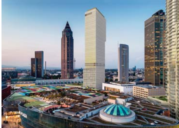
In Bau befindlicher Tower One (Mitte) der österreichischen CA Immo in Frankfurt. In Deutschland wie Österreich ist der Leerstand weiter sehr niedrig
