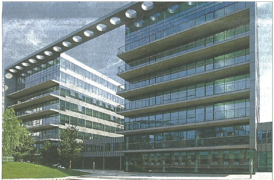
Das „Biz Zwei“ ist eines von sechs neuen Büroprojekten im Viertel Zwei am Standort Wiener Krieau.
